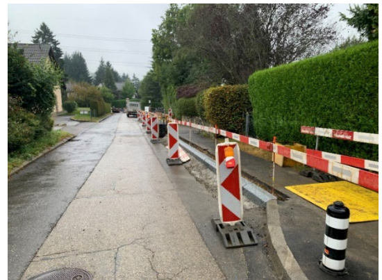
POSE DES BORDURES
