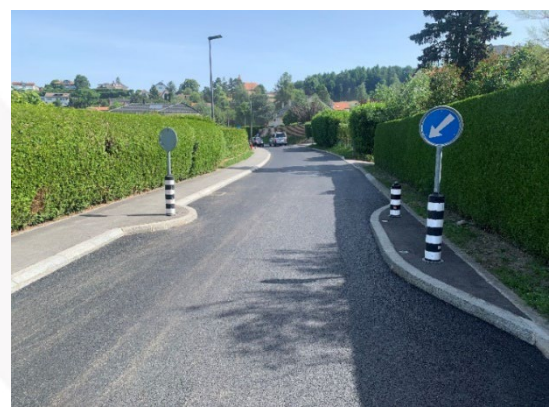
POSE DU TAPIS BITUMINEUX
